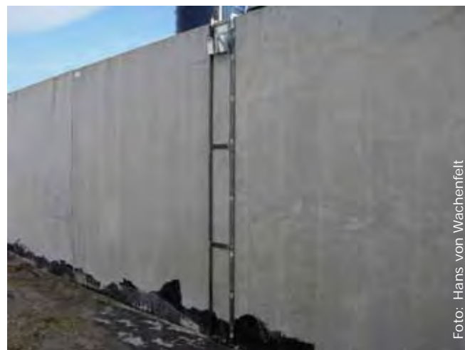
Figur 1. Silovägg med mätutrustning före inläggning.
